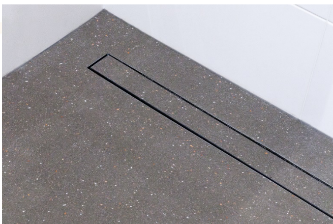
Afbeelding 5 – Troffelvloer, drain is gesmeerd met troffel
